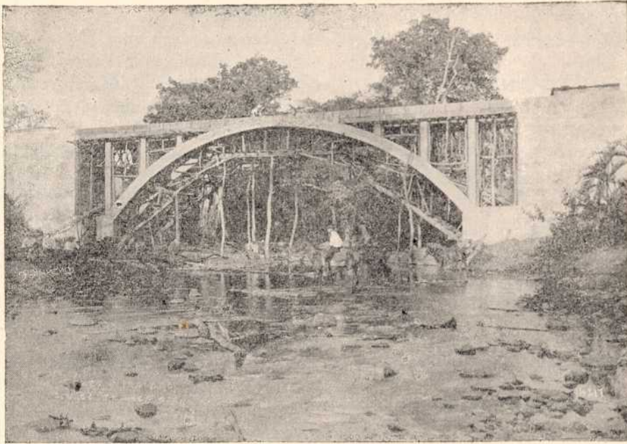
Puentes de Costa Rica
