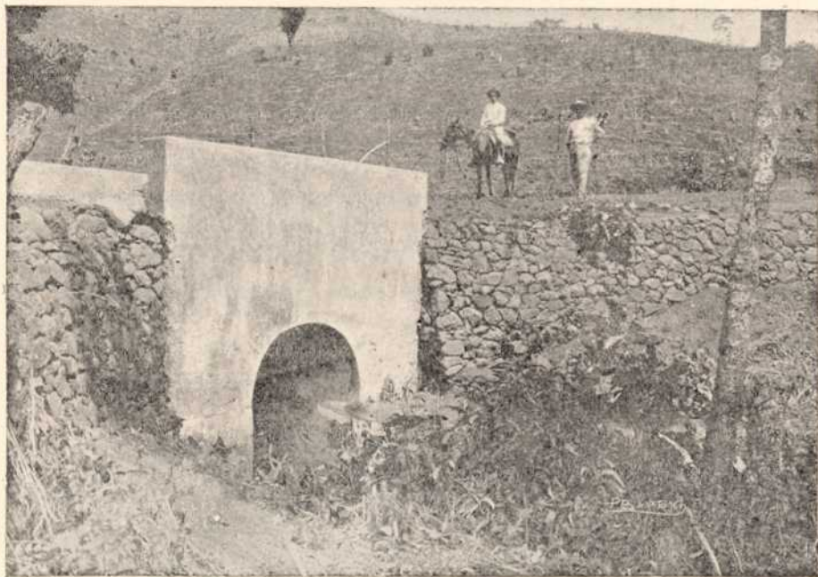
Puentes de Costa Rica
