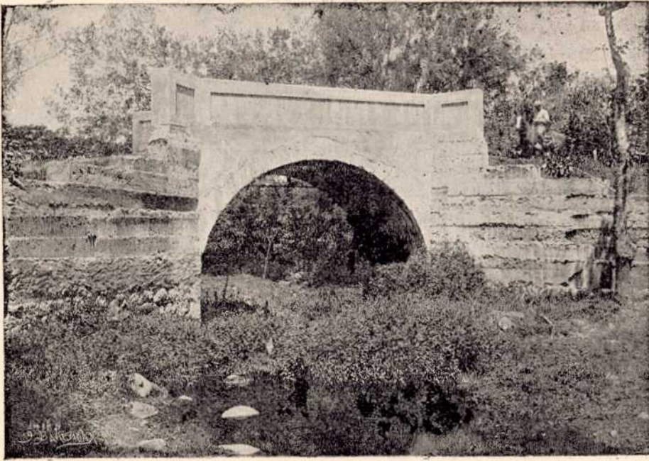
Puentes de Costa Rica
